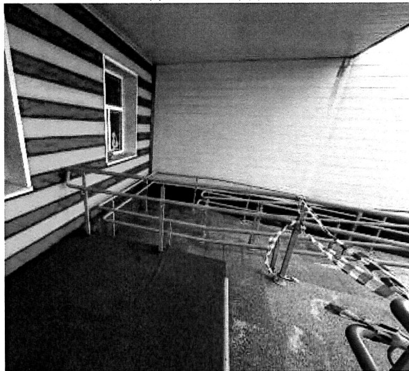
ФОТО № 30 Входная площадка
