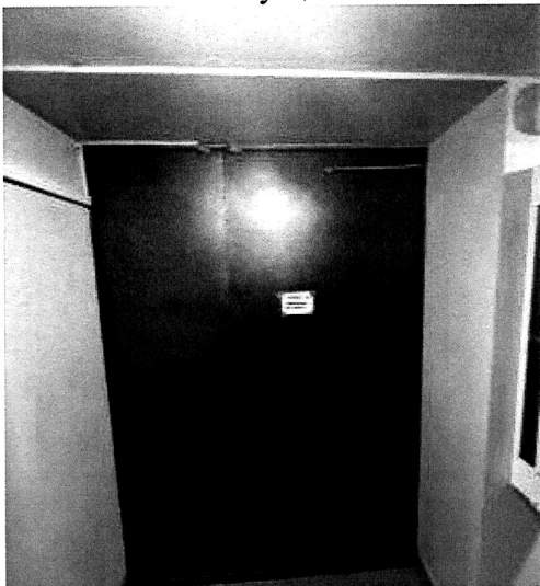
ФОТО № 107 Эвакуационный выход
