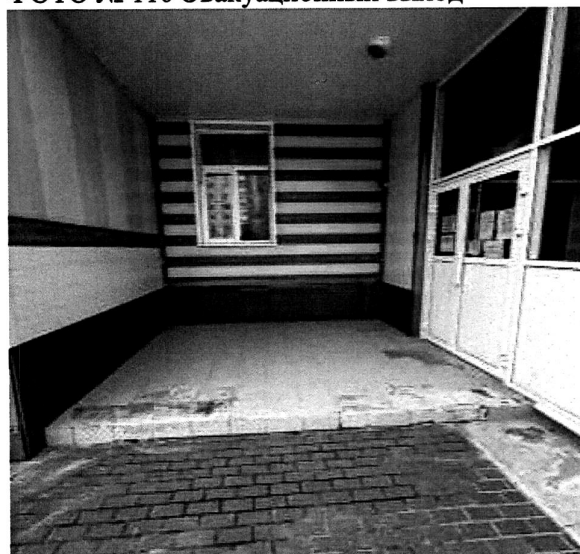
ФОТО № 110 Эвакуационный выход
