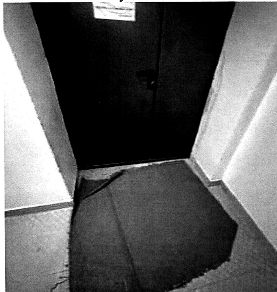
ФОТО № 118 Эвакуационный выход
