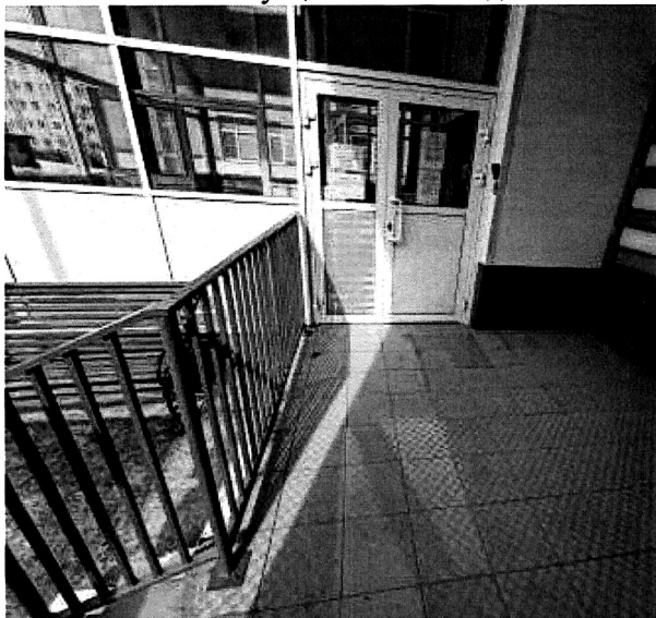
ФОТО № 125 Эвакуационный выход
