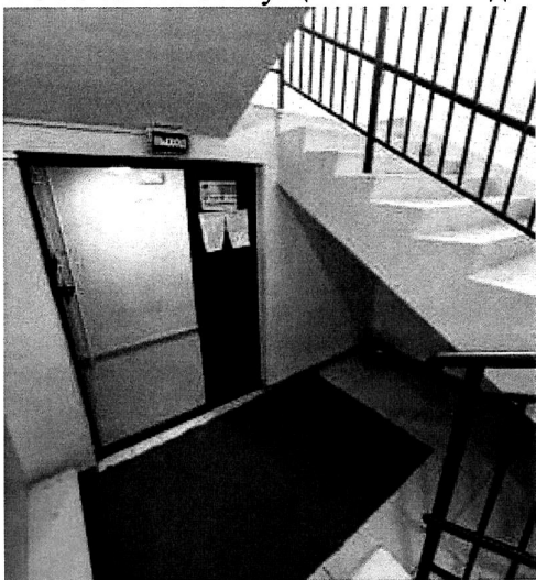
ФОТО № 113 Эвакуационный выход
