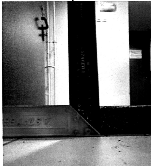
ФОТО № 116 Эвакуационный выход
