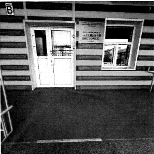
ФОТО № 29 Входная площадка
