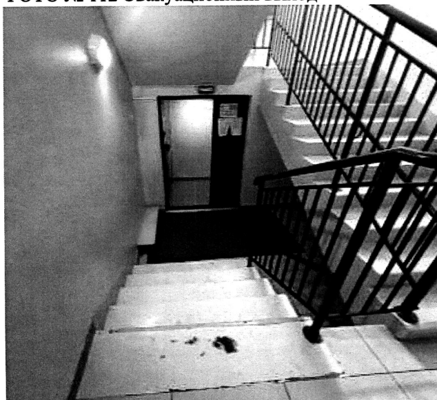
ФОТО № 112 Эвакуационный выход
