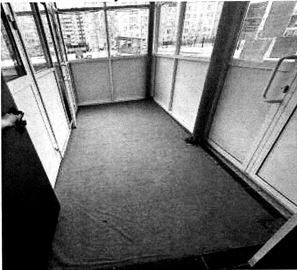
ФОТО № 119 Эвакуационный выход
