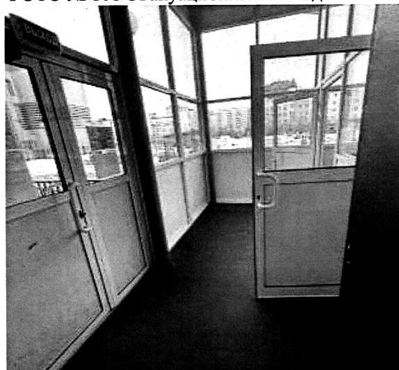
ФОТО № 108 Эвакуационный выход
