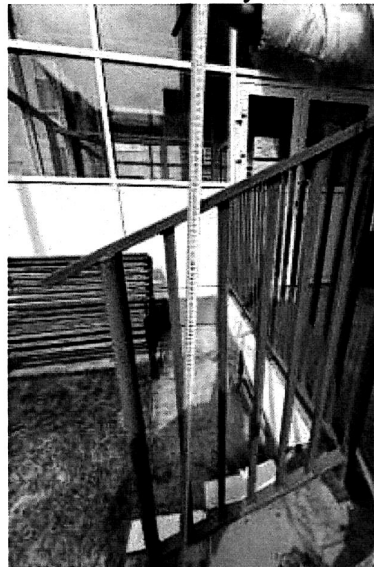
ФОТО № 126 Эвакуационный выход
