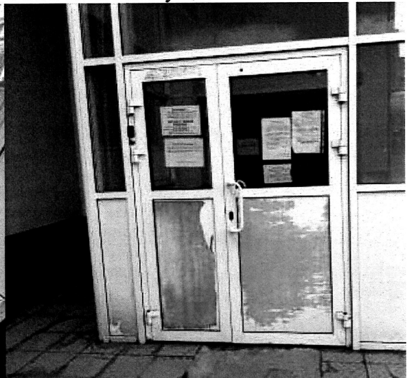
ФОТО № 120 Эвакуационный выход
